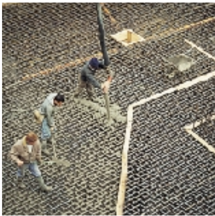
Détail du bétonnage du radier avec un béton superfluide grâce à MAPEFLUID PZ500
