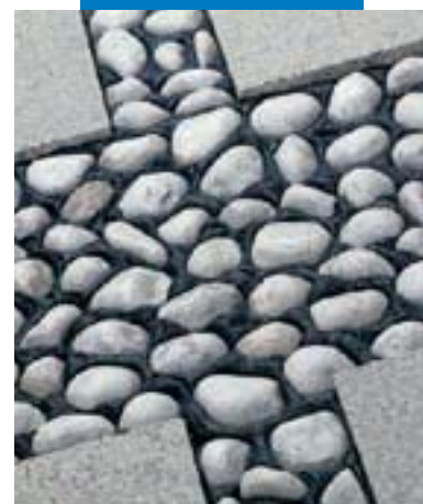
Exemple de jointoiment de pierres décoratives
