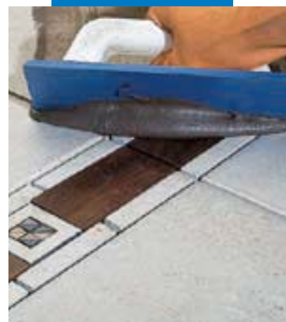
Jointoiment, à la spatule, de carreaux ceramique avec insertion de bois
