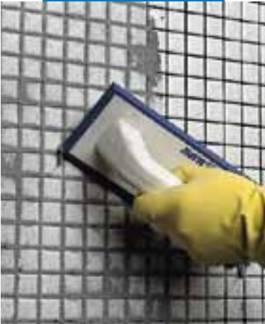
Jointoiment de pâte de verre en salle de bains
