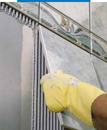
Pose de grès émaillé en mur, sur plâtre cartonné
