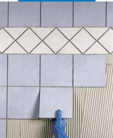
Pose de grès émaillé en mur, sur enduit de ciment dans une salle de bains
