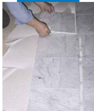
Pose de marbre de Carrare sur support bois avec Keralastic blanc
