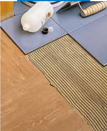
Pose sur ancien revêtements en PVC
