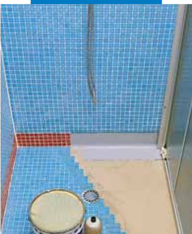
Pose dans une douche préfabriquée
