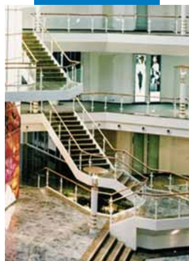
Pose de carrelage ou de marbre sur structure métal (escalier)
