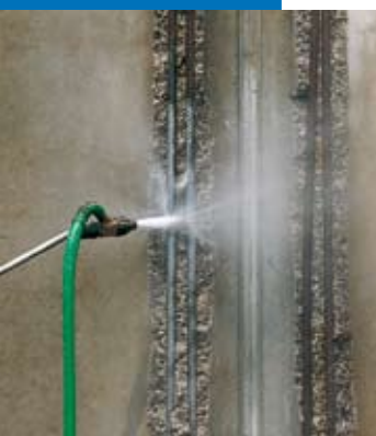
Décapage des fers par hydrosablage
