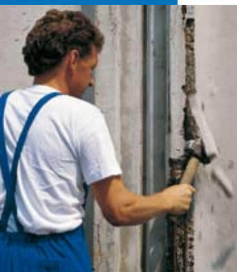
Démolition du béton dégradé
