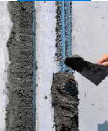
Application sur béton
