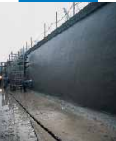
Canal hydroélectrique Bertini - Robbiate (Como - Italie): vue d'ensemble
