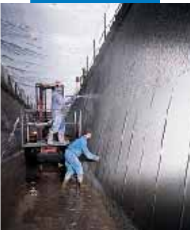
Canal hydroélectrique Bertini - Robbiate (Como - Italie): lissage
