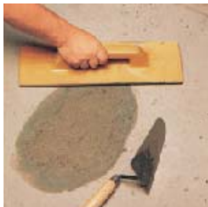
Réparation d'une chape: lissage final
