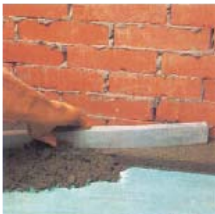
Application d'une chape ciment adjuvantée de PLANICRETE
