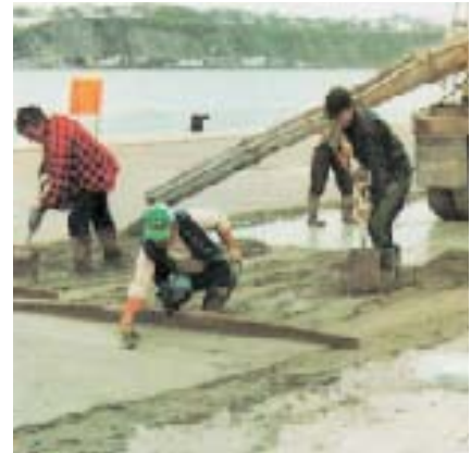
Chape ciment adjuvantée de PLANICRETE. Chantier Vieux Port, Quebec, Canada.
