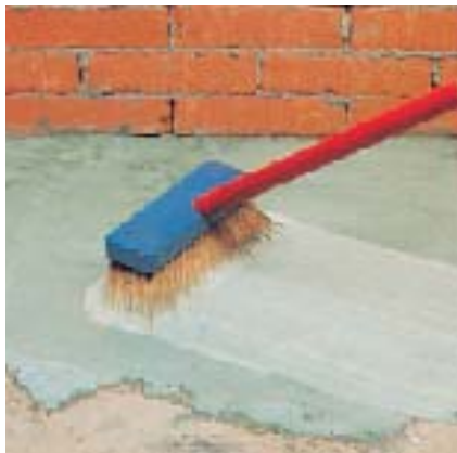
Application d'une barbotine d'accrochage adjuvantée de PLANICRETE
