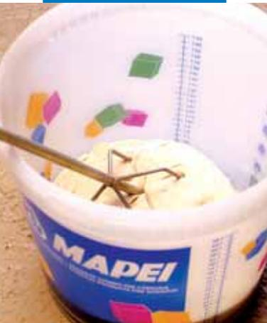
Mélange de Mapeset avec un agitateur mécanique
