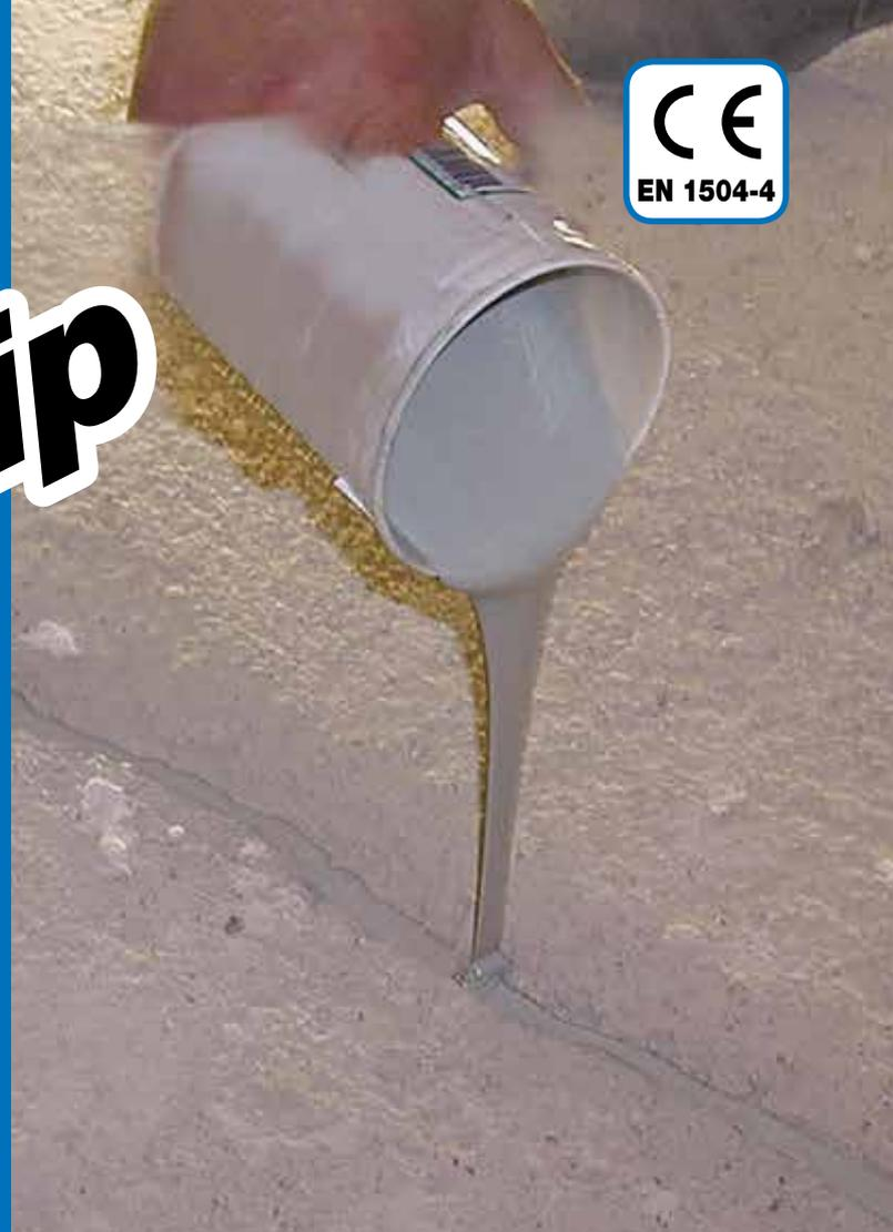
**Colle époxy bicomposant, exempte de solvant, pour reprises de bétonnage et traitement monolithique des fissures présentes dans les chapes**
