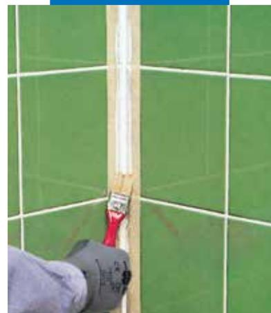
Lissage du joint avec de l'eau savonneuse et un petit pinceau
