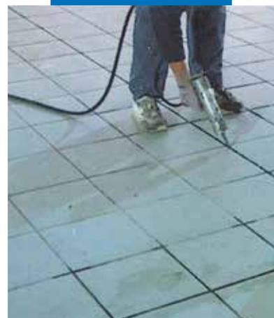
Jointoiement d'un sol carrelage avec Mapesil AC
