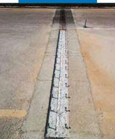
Rénovation de joint de pont d'autoroute avec Mapecfill
