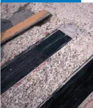
Plats Carboplate engravés dans le béton
