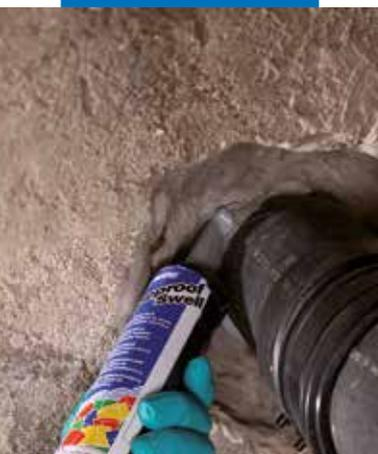
Rebouchage d'un élément à travers en utilisant Mapeproof Swell
