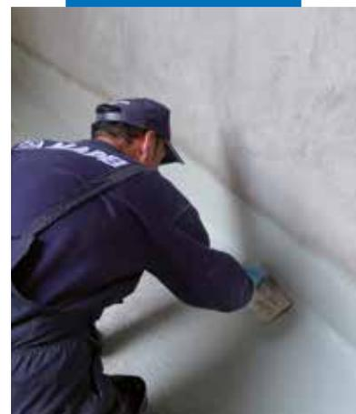
*Mapelastic Foundation appliqué à la spatule pour imperméabiliser le sol de l'eau en contre-pression*
