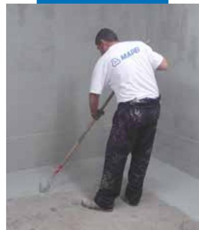
*Mapelastic Foundation appliqué au rouleau pour imperméabiliser le sol de l'eau en contre-pression*
