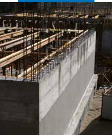
Mur de fondation rendu imperméable après moulage en utilisant Mapelastic Foundation
