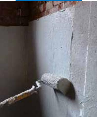
Application de Mapelastic Foundation au rouleau sur un support égalisé en utilisant Planitop HDM Maxi
